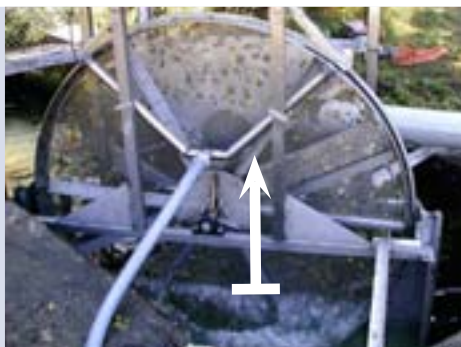
Vue arrière du dégrilleur
